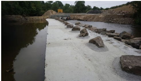
Arasement de l'ouvrage et pose d'un double radier (chantier en cours)
