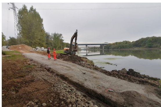
Création d'une cale au pont Jean-Moulin sur la Maine.
