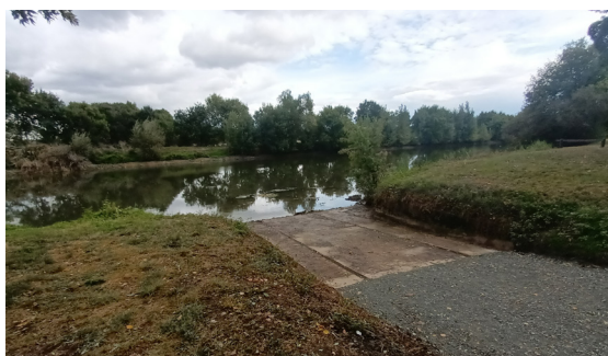
Restauration de la cale de mise à l'eau du Theil à Juvardeil.
