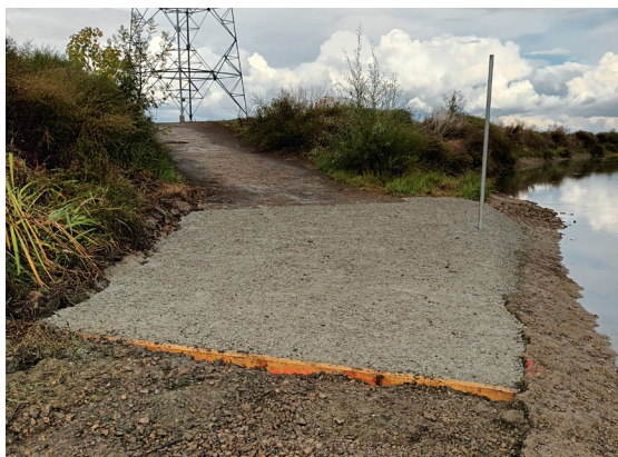
Allongement de la cale de mise à l'eau de la Baillie à Soulaire et Bourg.
