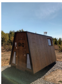
Installation de toilettes sèches.
