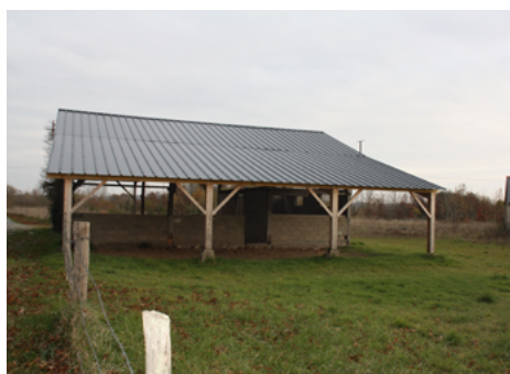
Mise en place d'un abri.
