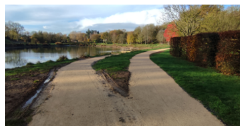
Terrassement des chemins d'accès au ponton et aux sanitaires au plan d'eau de Vihiers.
