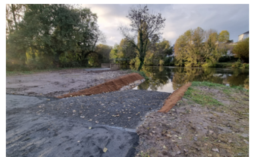
Nouvelle cale de mise à l'eau à Durtal.
