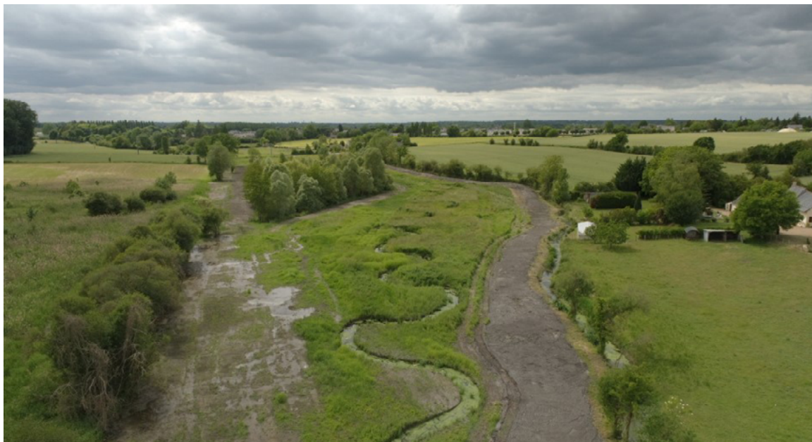
Aperçu depuis un drone des travaux de restauration menés sur le ruisseau de Marcé.
