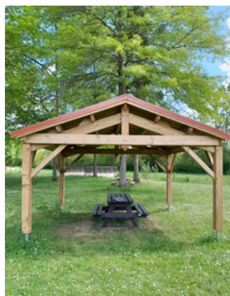
Installation d'un abri.
